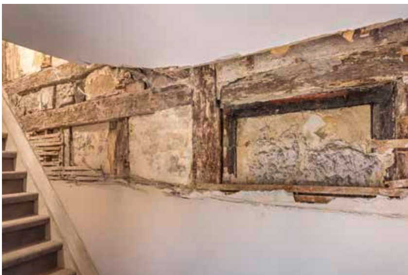
Ständerwand im 1. Obergeschoss. Die dendrochronologische Untersuchung ergab das Jahr 1452 – exakt dasselbe Jahr, in dem gemäss einer überlieferten Urkunde die beiden Haushälften in verschiedene Hände kamen und daher eine Abtrennung errichtet wurde. Auf der Ausfachung im rechten Bildbereich ist noch die historische Farbfassung zu sehen.
