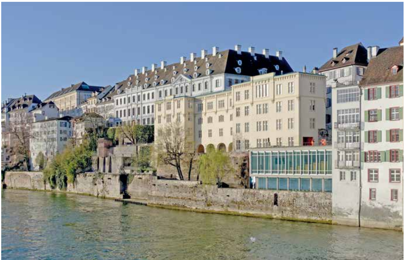
Die Rheinufermauer vor der Sanierung 2020.
