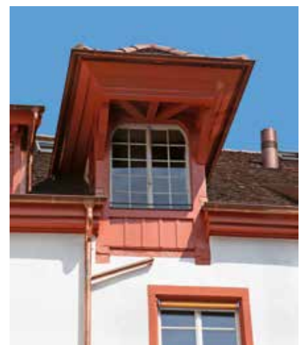
6 – Die 1620 eingebaute Aufzugsgaube auf der Rückseite der Liegenschaft. Ursprünglich hatte die Gaube nur hölzerne Klappläden.
