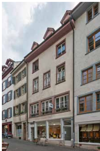
1 – Schneidergasse 24 vor der Sanierung. Im 3. Obergeschoss wurden bei der Putzsanie-rung Reste der mittelalterlichen Fenster-gewände entdeckt.
